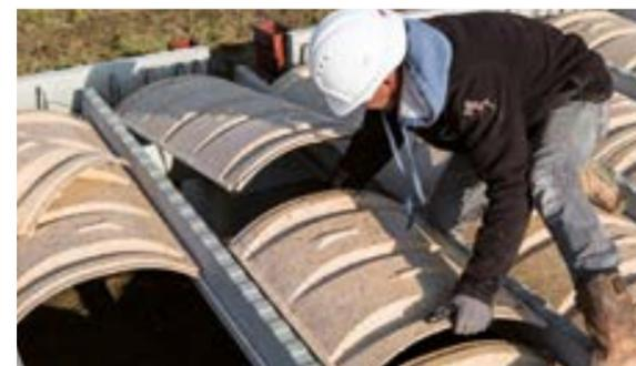
■ Pose des poutrelles et des entrevous puis coulage de la dalle avec les fondations en une seule opération. Vibrer le béton dans les plots pour une meilleure répartition.
