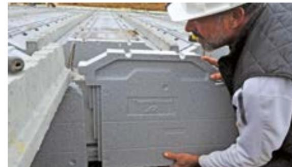
■ Le ThermoRefend® sert également de rupteur pour traiter la poutre PSR.
