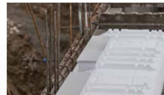
■ Placez les rupteurs en rive en respectant le plan de préconisation de pose fourni, planter 2 points d'ancrage à l'oblique pour consolider la pose. Ne pas percer la dalle coupe-feu.
