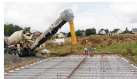
■ Le plancher est prêt à être coulé : déversez et vibrez le béton de façon uniforme à partir des appuis vers le centre, pour éviter toute concentration de poids.
