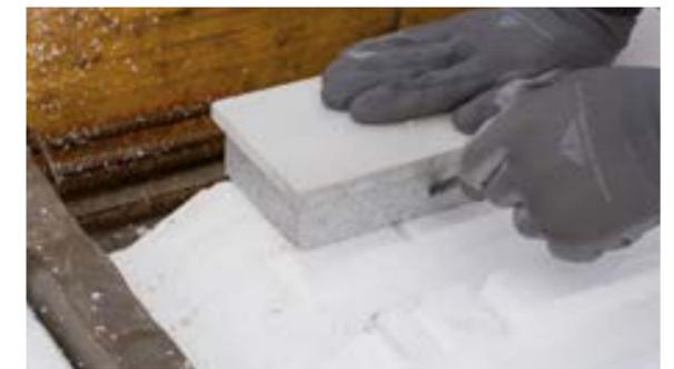
■ Placer les rupteurs en about, planter 2 pointes d'ancrage à l'oblique pour consolider la pose. Ne pas percer la plaque coupe-feu.
