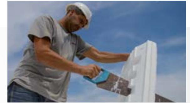
■ Découpe aisée des entrevous en sens transversal et longitudinal pour la pose des derniers entrevous ou la réalisation d'un faux entraxe.
