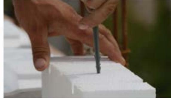
■ Les rupteurs d'about et de rive s'emboîtent parfaitement sur le RectoSten® Coffrant.
