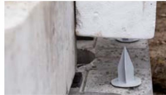
■ **Coffrage PSE** : permet de coffrer au niveau des plots. Le coffrage se positionne facilement grâce à l'utilisation de 2 RectoConnect.
