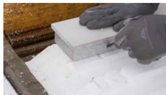
■ Placez les rupteurs en about, planter 2 points d'ancrage à l'oblique pour consolider la pose. Ne pas percer les plaques situées en haut du rupteur. Elles permettent d'assurer l'étanchéité et la résistance au feu de 15 minutes.
