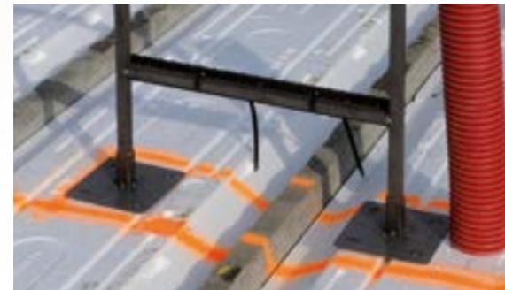
■ Fixation du Railfix sur la traverse basse du support à l'aide de Rilsan.
