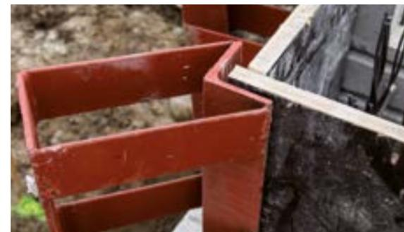
■ **Équerres de coffrage**. Les équerres permettent un positionnement juste des différents éléments de coffrage en périphérie de plancher.
