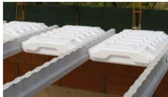
■ La pose débute par un demi RectoSten® Coffrant, en appui sur le mur. Les RectoSten® Coffrant permettent de régler l'espacement des poutrelles.
