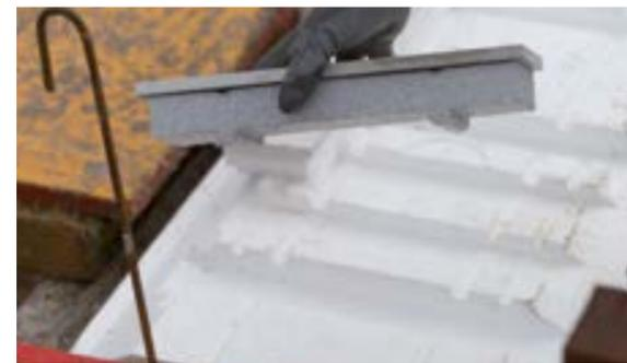
■ Les rupteurs s'emboîtent dans les RectoSten® Nervuré.
