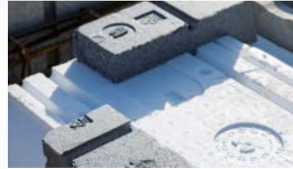
■ Dans les angles, placez des demi-rupteurs afin de respecter l'emplacement du ferrillage. Découpez les rupteurs en deux et placez la chute de l'autre côté.
