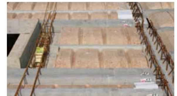
■ Le chevêtre permet de supporter les poutrelles interrompues par la présence de la trémie. Les charges apportées par le chevêtre sont reprises par les poutrelles situées de part et d'autre de la trémie. Le nombre de poutrelles en renfort est fonction des dimensions de la trémie et des charges ramenées sur le chevêtre.
