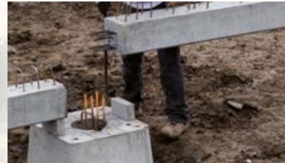
■ Utilisation possible de cales en béton pour régler l'altimétrie sous les longrines.
