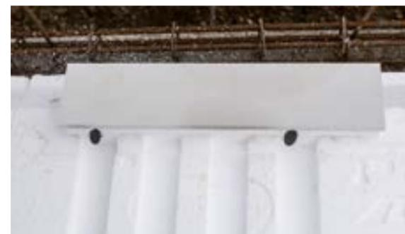
■ Placez les rupteurs en rive en respectant le plan de préconisation de pose fourni, planter 2 pointes d'ancrage à l'oblique pour consolider la pose.
